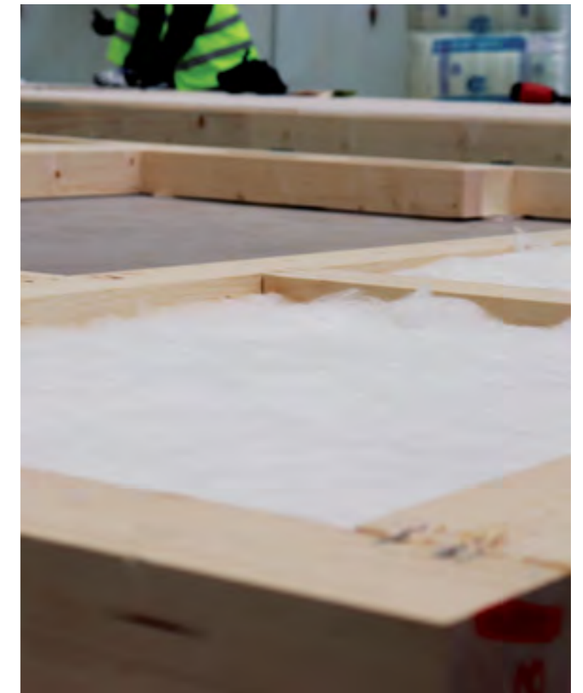
Applicazione della coibentazione nel sistema costruttivo
